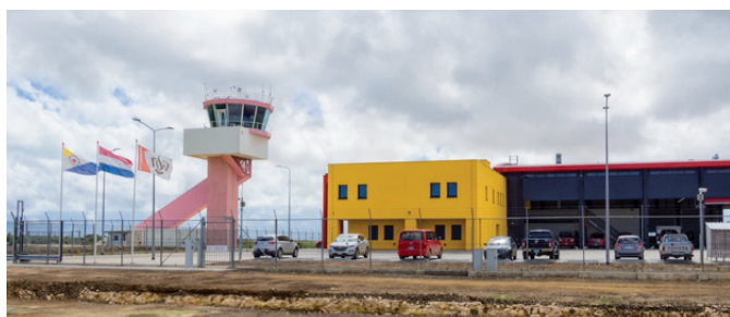
Overzicht van de nieuwe luchtverkeersleidingstoren en de brandweerkazerne. De Brandweerkazerne heeft een air-side (luchthaven, crashtenders) en een land-side (de rest van het eiland).
